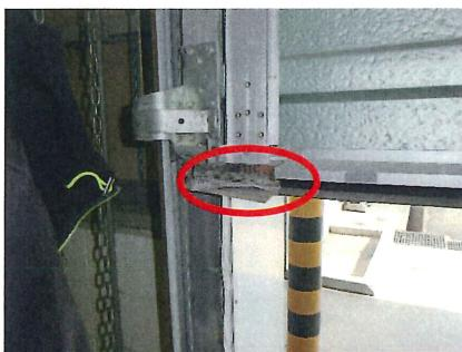
ダンプレートで隙間を塞ぐ
